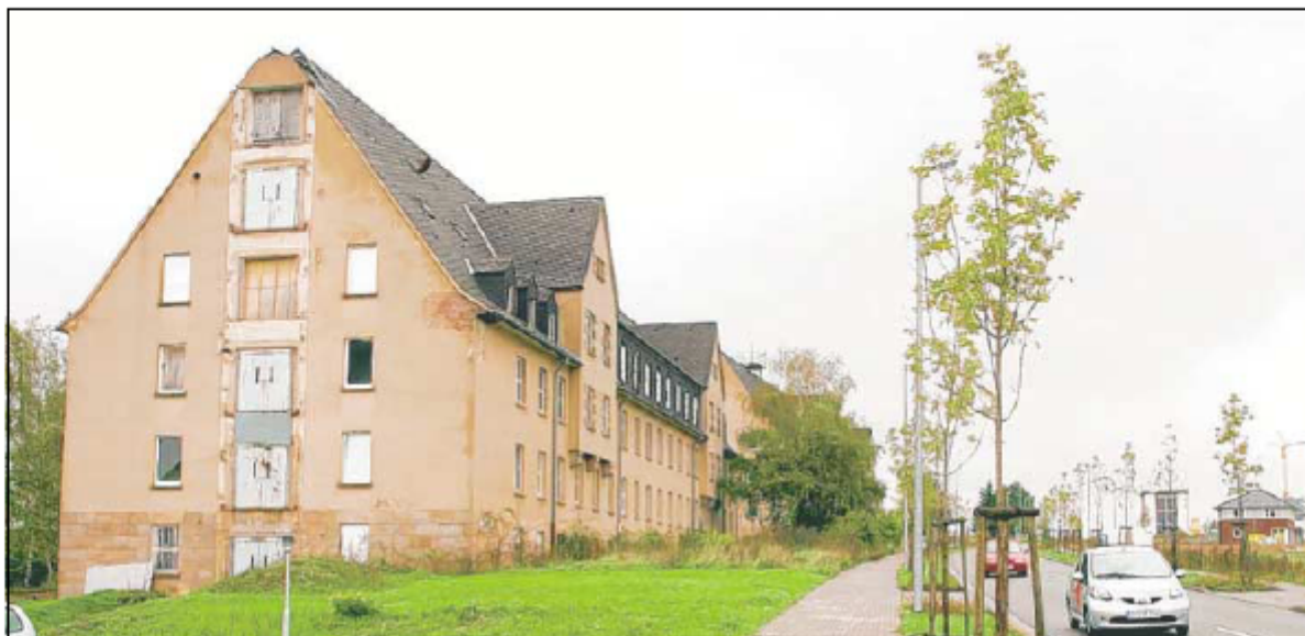
Das ehemalige Kasernengebäude, das die Gewobau für Comlet renovieren will.
